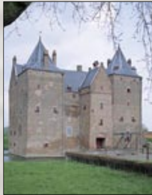
Warmtepompen in Slot Loevestein.
